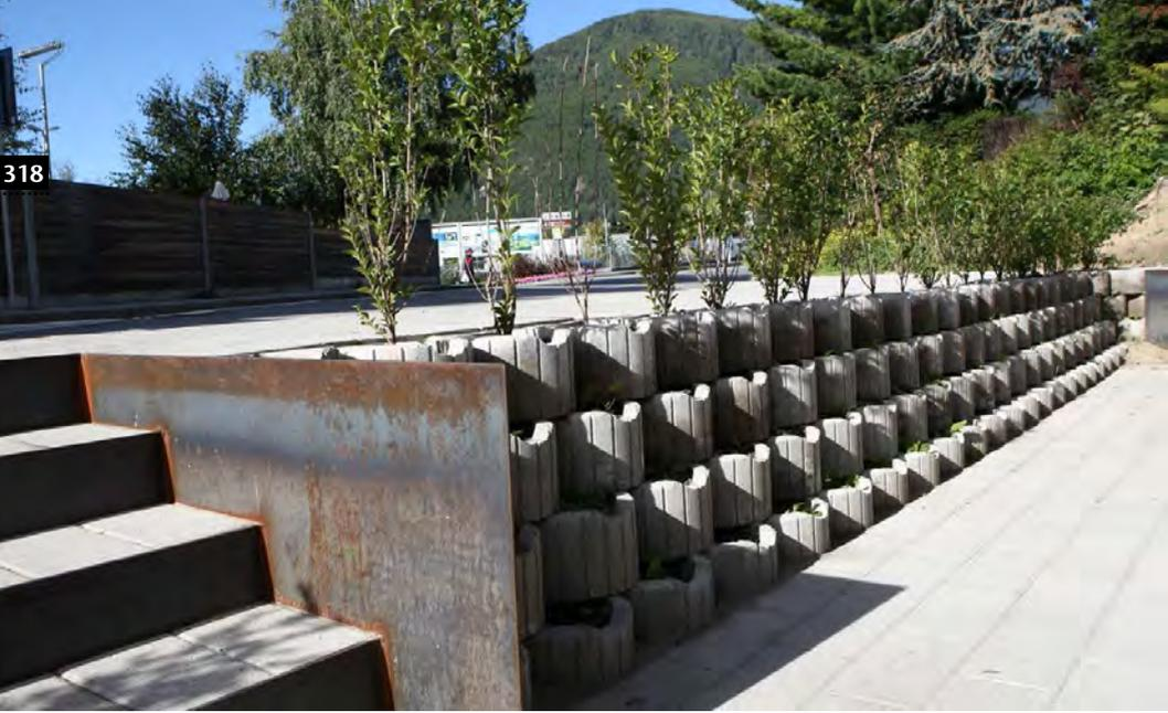
Dieser sollte aus einer standfesten, wasserdurchlässigen und frostsicheren Tragschicht bestehen, auf die anschließend eine Bettung aus
