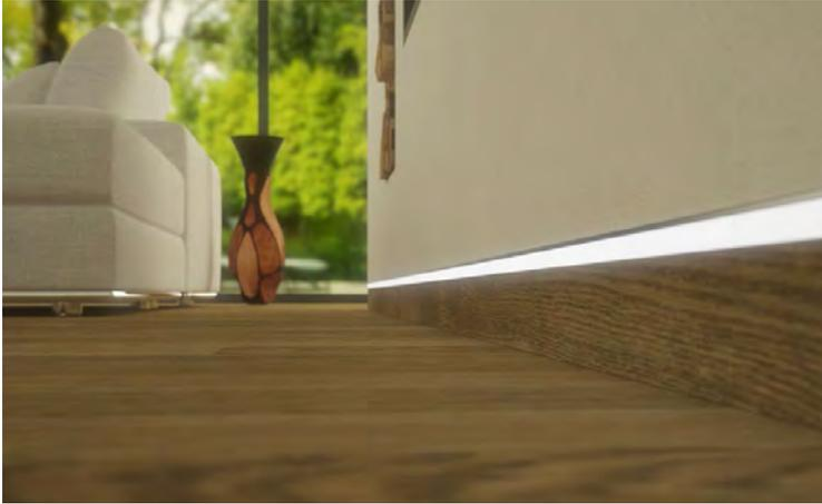
zung und Beschädigung. Man kann sie weglassen, wenn der Bodenbelag dies erlaubt und sauber an die Wand angepasst werden kann. Ein unempfindlicher Wandbelag oder eine sorgsame Behandlung sind dann vonnöten. Gestalterisch ist zu entscheiden, ob die Sockelleiste zur Wand (flächenbündig), ob sie zum Boden gehört oder ob sie sich als selbständiges Element dazu verhalten soll.
