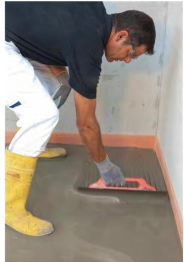
*Die Masse wird mit mit einer Zahntraufel vollflächig aufgetragen. Anschließend wird die Fläche mit einem Entlüftungsroller, zum Entfernen von eingeschlossenen Luftblasen und zur Vermeidung von Unebenheiten, bearbeitet.*
