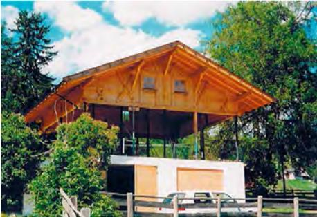
**Selbst ganze Stockwerke samt Außenholzwände können gehoben werden.**
