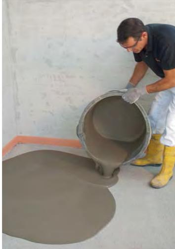
*Die Bodenausgleichsmasse wird aufgetragen. Es soll nicht mehr Material angemischt werden, als innerhalb 30 Minuten verarbeitet werden kann.*
