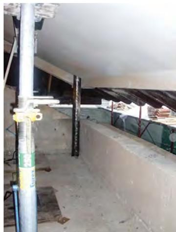
*Die hydraulische Dachanhebung ist bei allen Baustoffen anwendbar, und selbst bei Stahlbeton möglich.*
