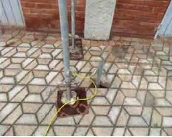
**Gerüstfuß mit Lastverteilungsplatte und Erdungsanschluss**
