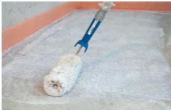
**Mit der Rolle wird die universell einsetzbare, lösemittelfreie Grundierung aufgetragen. Die Trocknungszeit ist abhängig vom Untergrund und der Nachfolgeschichtung.**
