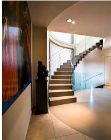
eine Treppenart, bei denen die einzelnen Stufen keine Auflager haben. Der einzige Halt stellt eine wandseitige Verankerung fest. Auf der Lichtseite verläuft das Treppengeländer,
