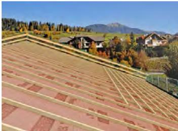
höchsten Stand der Technik ist daher das gezielt dampfdiffusionsoffene Dach. Um dies zu planen, müssen offene Fugen oder stärkere
