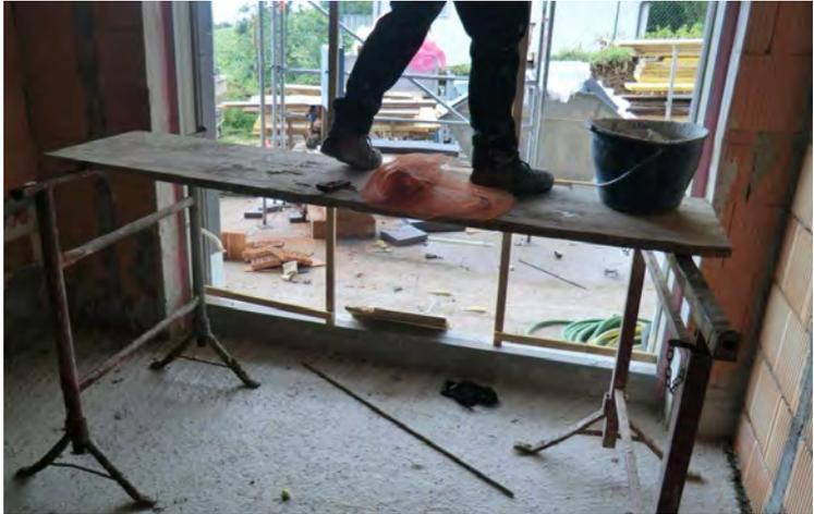
**Unsachgemäß errichtetes Bockgerüst**
