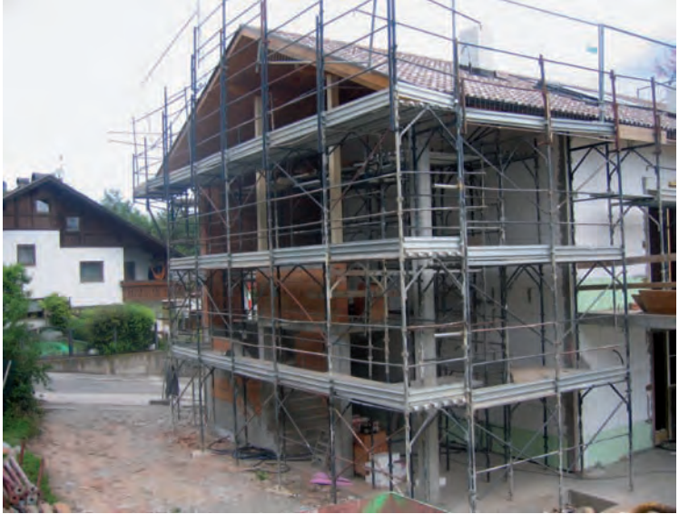
Ordnungsgemäß errichtetes Fassadengerüst
