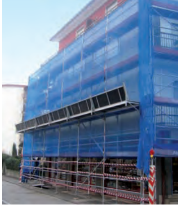
Ordnungsgemäß errichtetes Fassadengerüst
