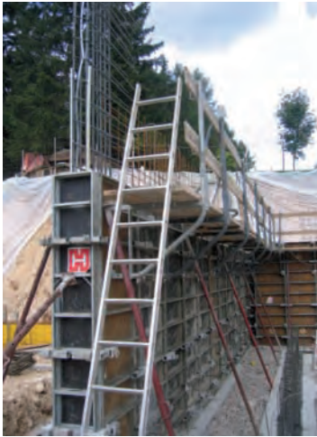
Betonarbeiten mit Konsolegerüst auf Schalung
