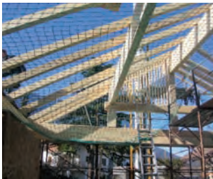
Zimmermannsarbeiten mit Auffangnetz als Absturzsicherung
